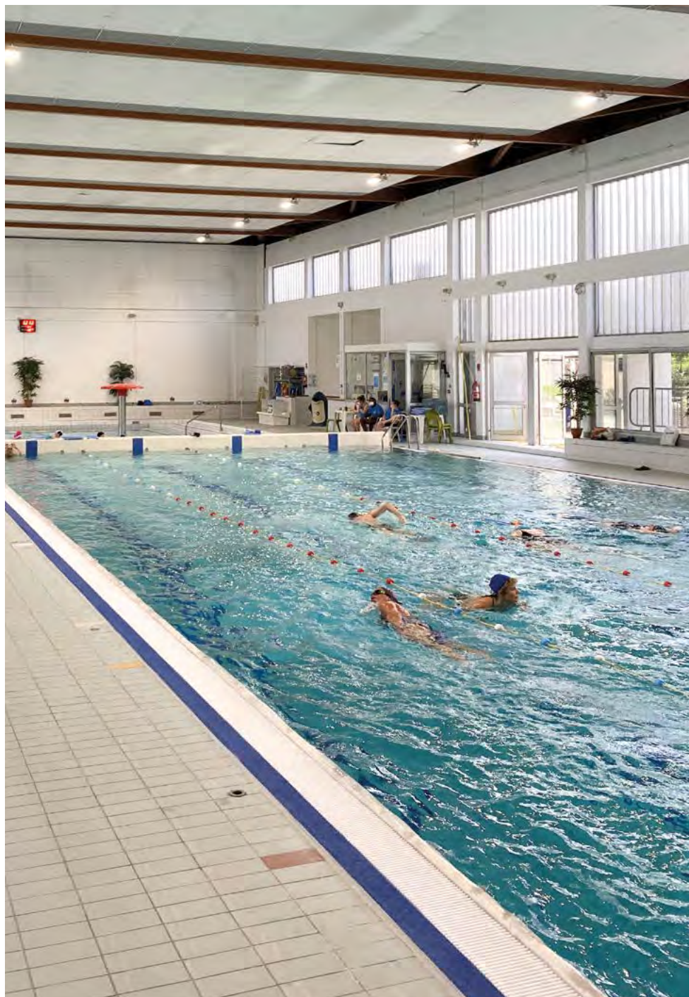
La piscine municipale Nelson-Mandela est située au 59 av. du Docteur Calmette.
